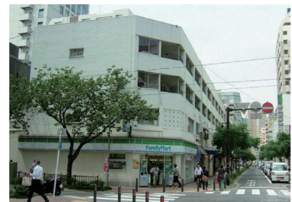
1954年竣工「弁三ビル」。 1階は店舗、2階以上が住宅という防火建築帯の典型的な構造となっている。
