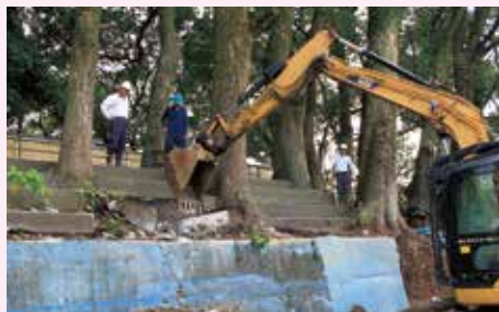
写真3 解体中の野球場
