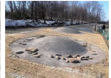
自然石＋土系舗装
