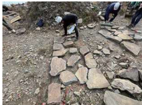
R4年度工事で使用した板石
