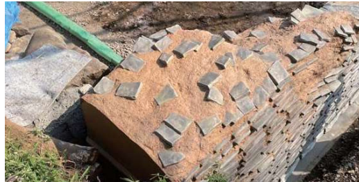
レプリカでの瓦積塀の表現（御用米曲輪）
