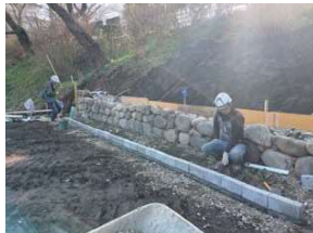
R4年度工事で使用した 玉石・板石
