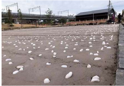
施工中【土系舗装＋玉砂利】（大友氏館跡）
