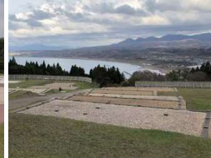
石材による縁取（勝山館）
