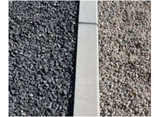
コンクリートによる縁取
