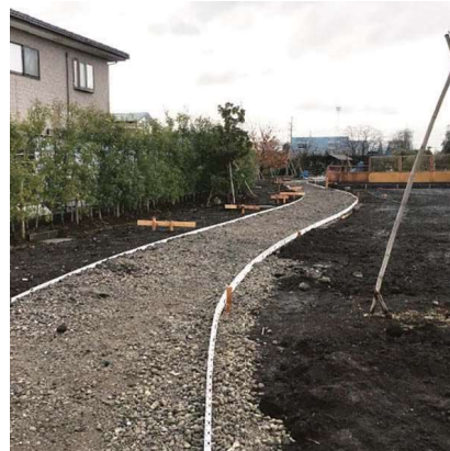
舗装の見切り材施工状況 ある程度の曲線は対応可能である
