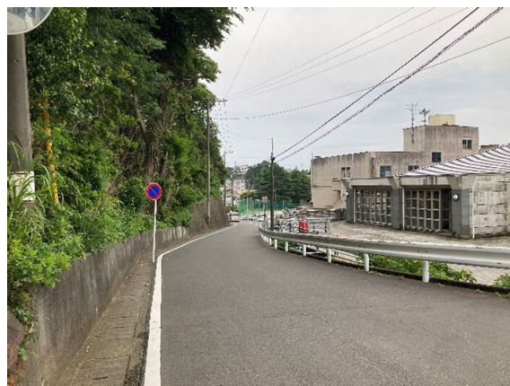
⑥東側道路との関係（町立体育館付近）
