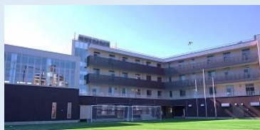
重量鉄骨・地上4階建て （基本・実施設計含め2年で完成）
