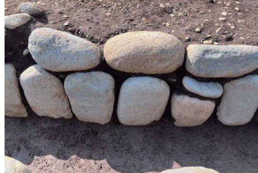
側：安山岩円礫・縦置き・天端石（横置き・横据え） 底：なし
