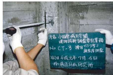
鉄筋被り暑さ・腐食度調査
