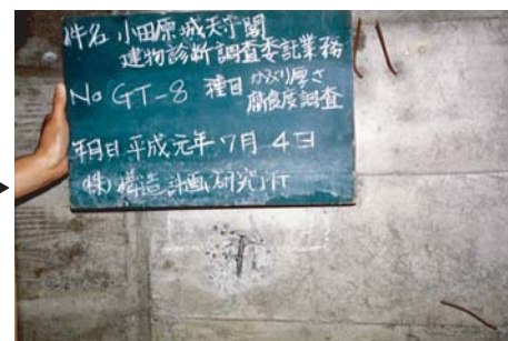
鉄筋被り暑さ・腐食度調査
