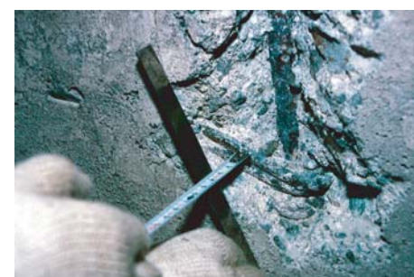
鉄筋被り暑さ・腐食度調査
