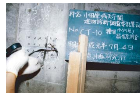
鉄筋被り暑さ・腐食度調査
