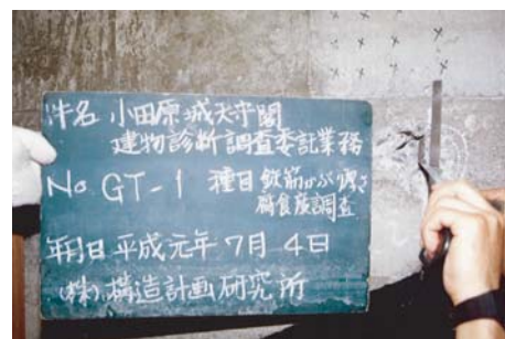
鉄筋被り暑さ・腐食度調査
