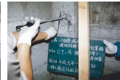
鉄筋被り暑さ・腐食度調査
