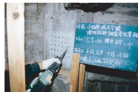
鉄筋被り暑さ・腐食度調査
