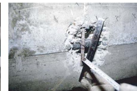
鉄筋被り暑さ・腐食度調査
