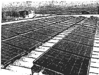
3~20kW容量ほどの 太陽光発電の設置
