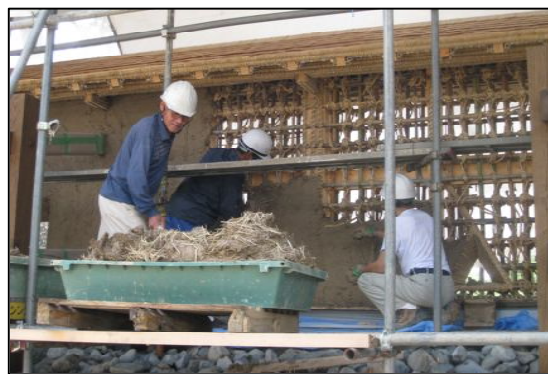
土塀の荒壁塗りの様子
