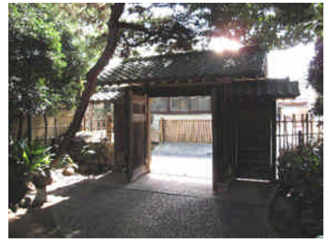
【南門内側より（倒壊前）】
